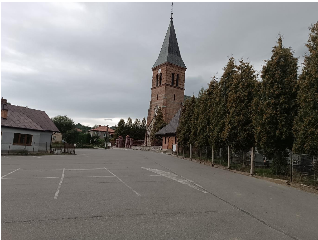
Fotografia 4. Widok od strony parkingu
